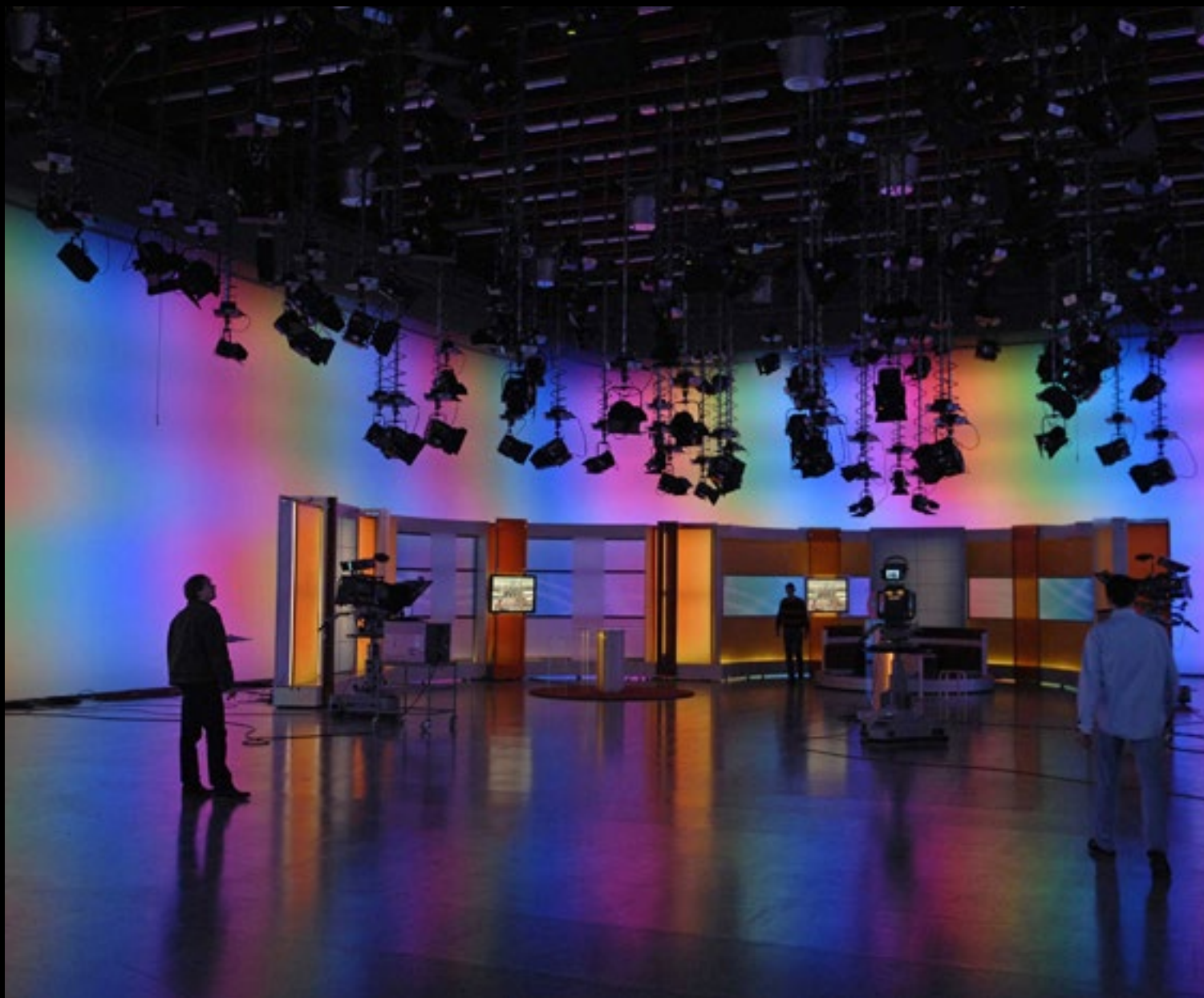
Radio Brandenburg, Studio 1, Berlin, Nemčija Ciklorama izdelana iz projekcijskega platna OPTITRANS (96x6,3 m) v kombinaciji z RGB LED diodami.
